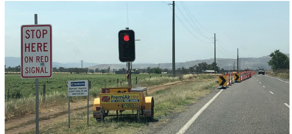
ไฟสัญญาณจราจรชั่วคราวบนถนน คุณต้องหยุดรถเมื่อไฟแดง
